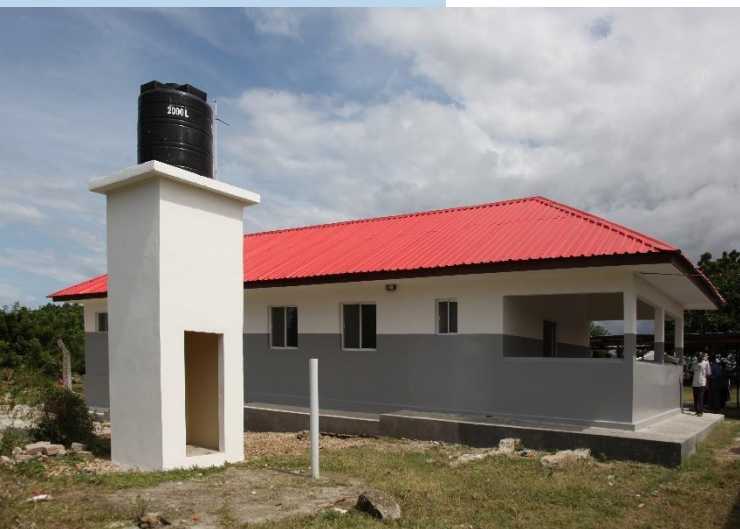
Centre de santé de Micheweni, construit par AMD à Pemba (Zanzibar)
